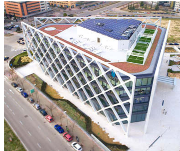
Azotea con dos pistas de pádel, pista de 'running' y área de ejercicio al aire libre con máquinas. GMP
