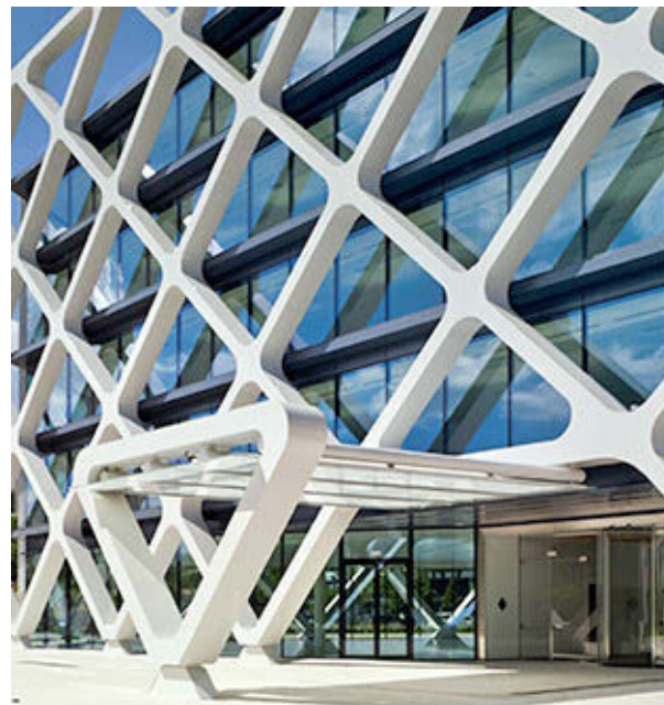
Celosía estructural con función de protección solar de la fachada. DAVID FRUTOS
