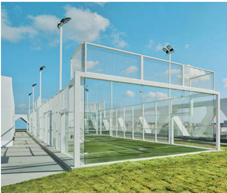
Consta de 2.000 metros en la parte superior del edificio donde se han instalado dos pistas de pádel . GMP
